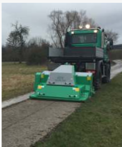
Aufgefräst, profiliert und verdichtet
